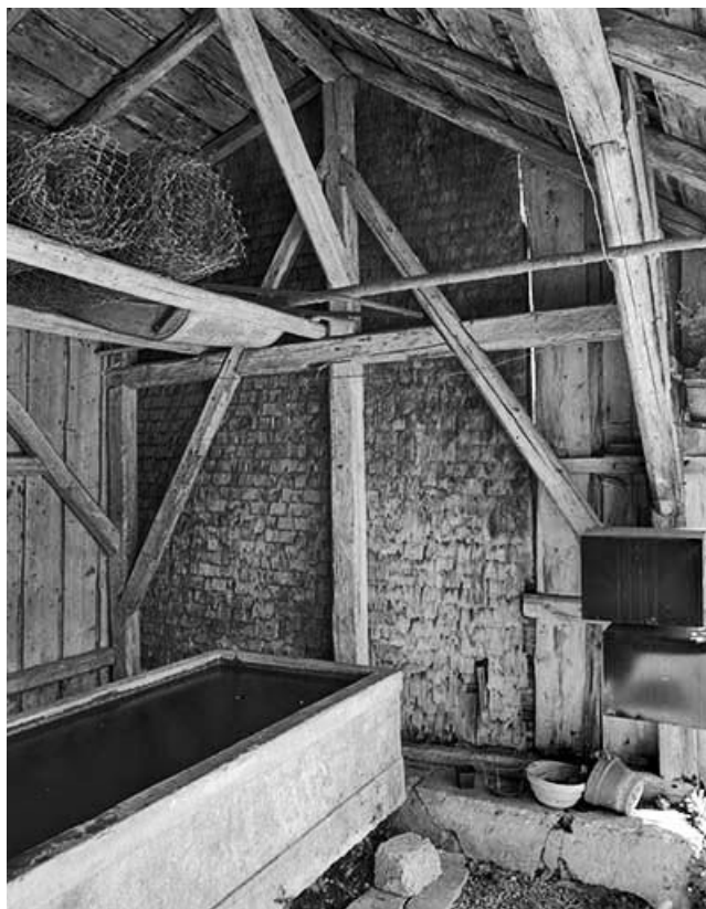
Vue de la charpente.
