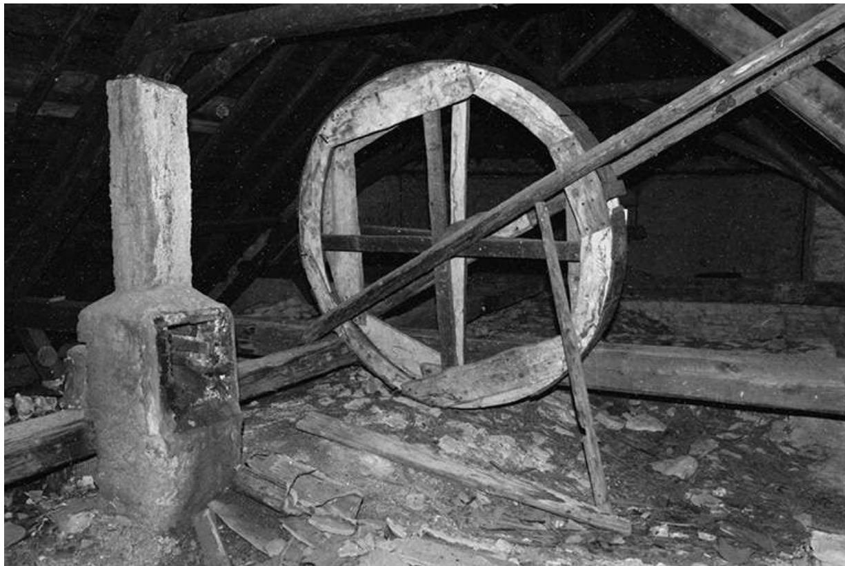
Combles : l'un des treuils.
