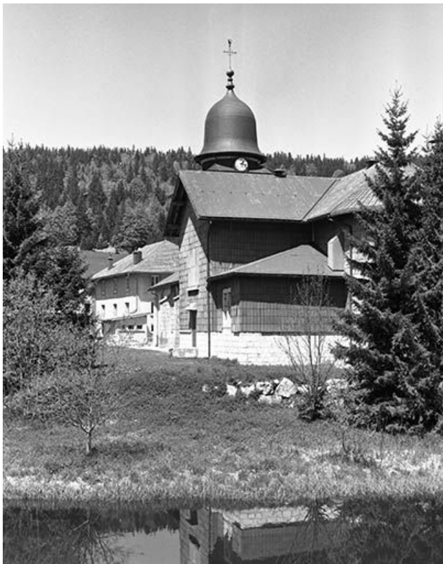
Vue de l'église depuis le sud.
