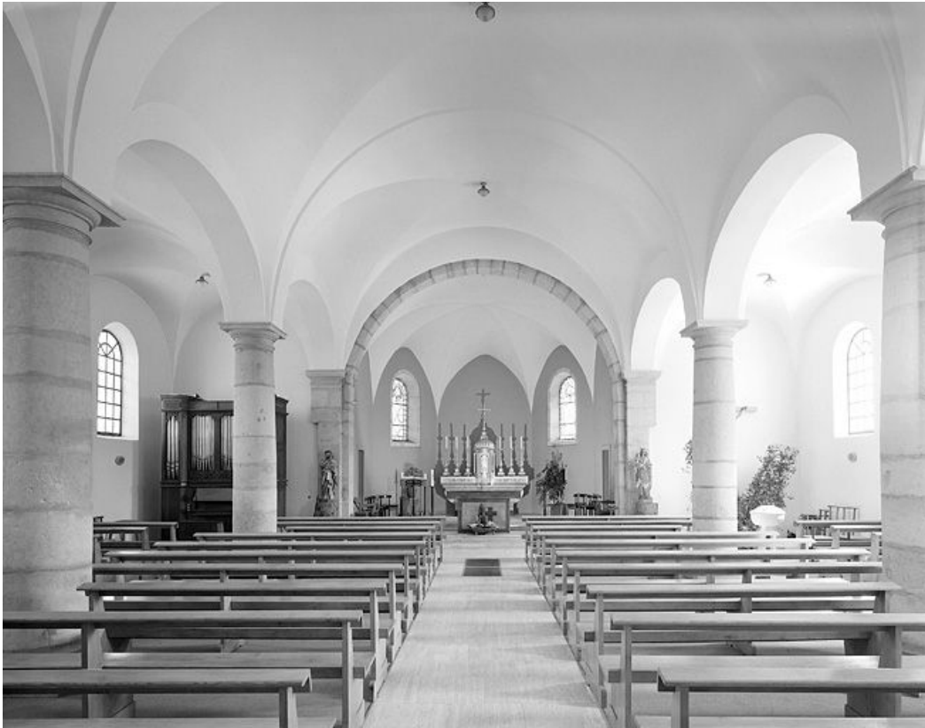
Le vaisseau central vu depuis l'entrée.
