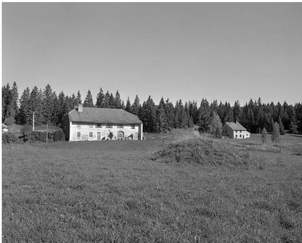
Façade antérieure, vue éloignée.
