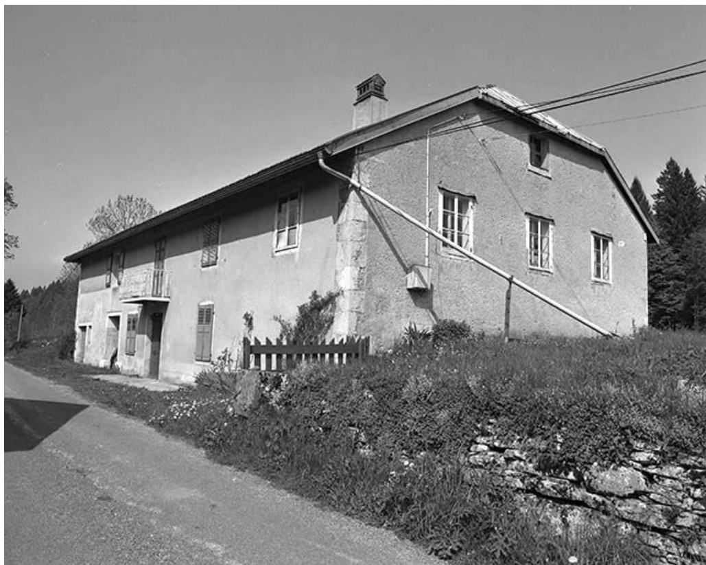
Façade antérieure et face droite.
