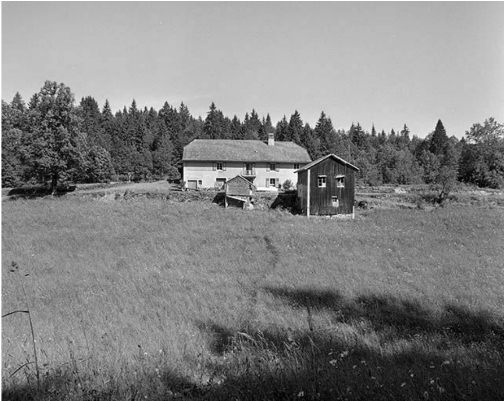
Façade antérieure, vue éloignée.
