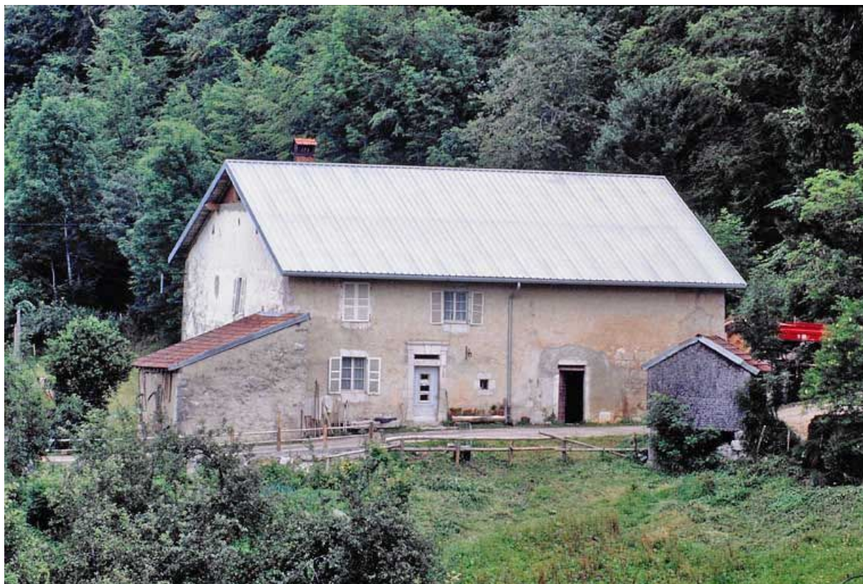
Vue éloignée de la façade antérieure.
