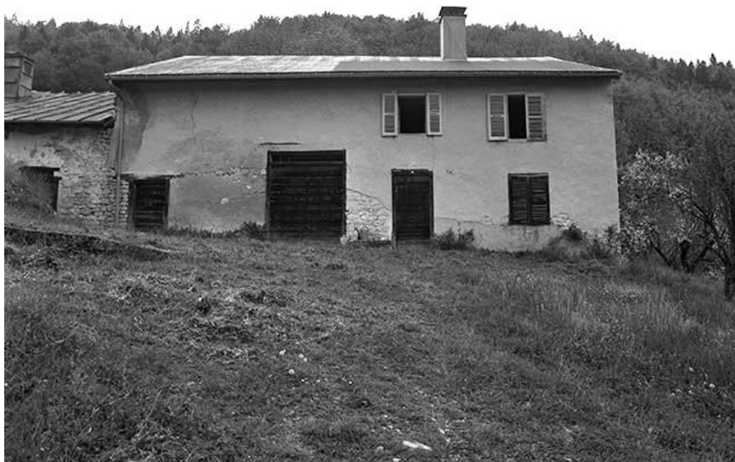
Partie droite de la façade antérieure.
