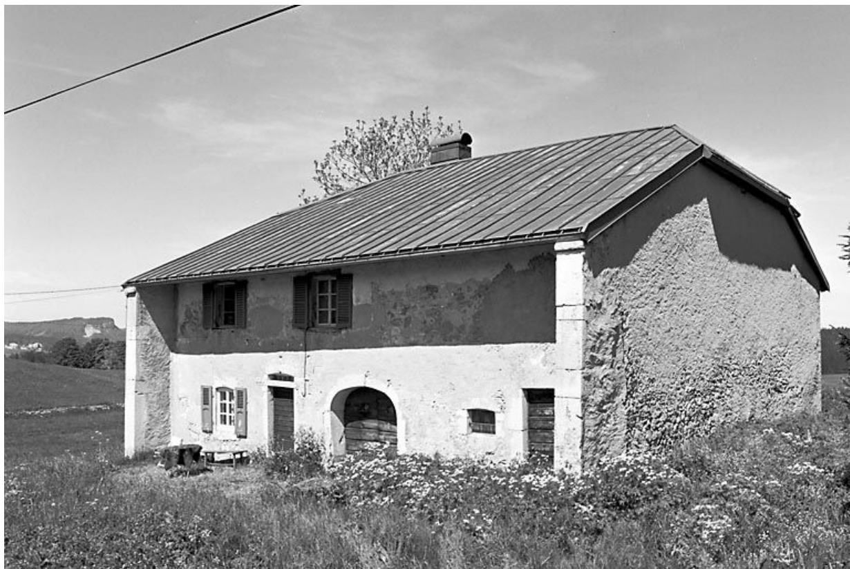
Façade antérieure et face droite.
