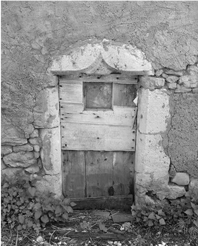
Linteau en accolade sur la façade postérieure.
