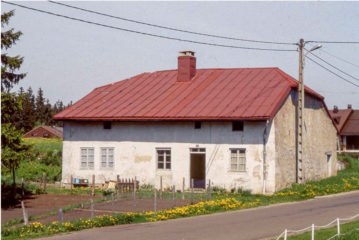
Façade antérieure et face droite.
