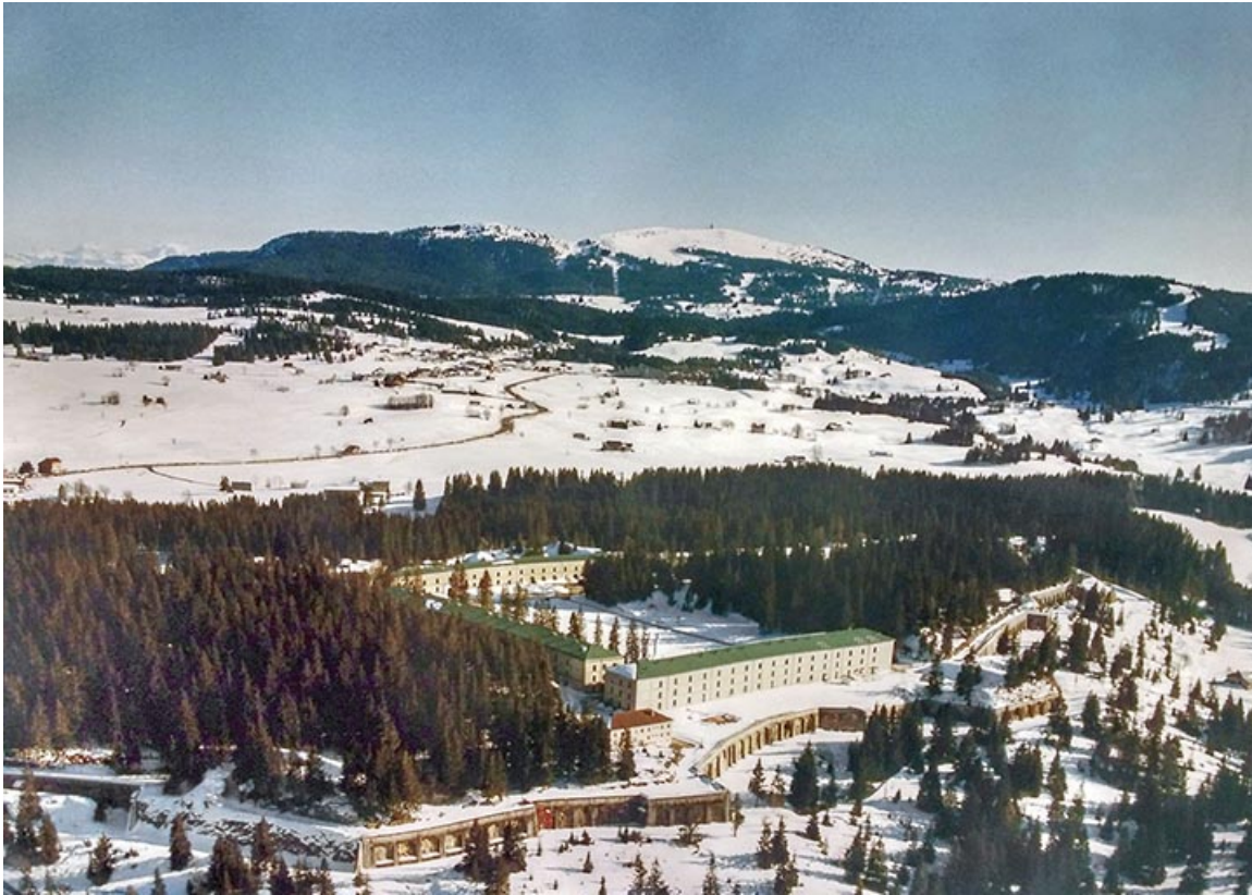
Vue aérienne générale du front ouest.
