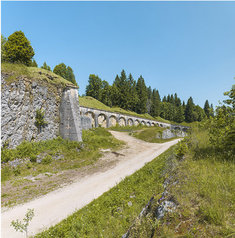
Front sud-est : vue générale.
