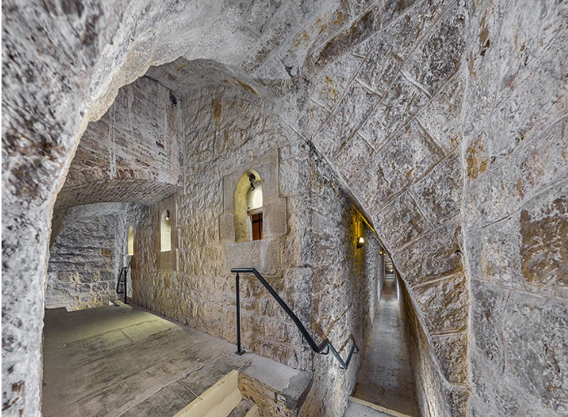
Le magasin à poudre. La galerie d'assainissement à droite et le vestibule d'éclairage à gauche. 39, Les Rousses R.N. 5
