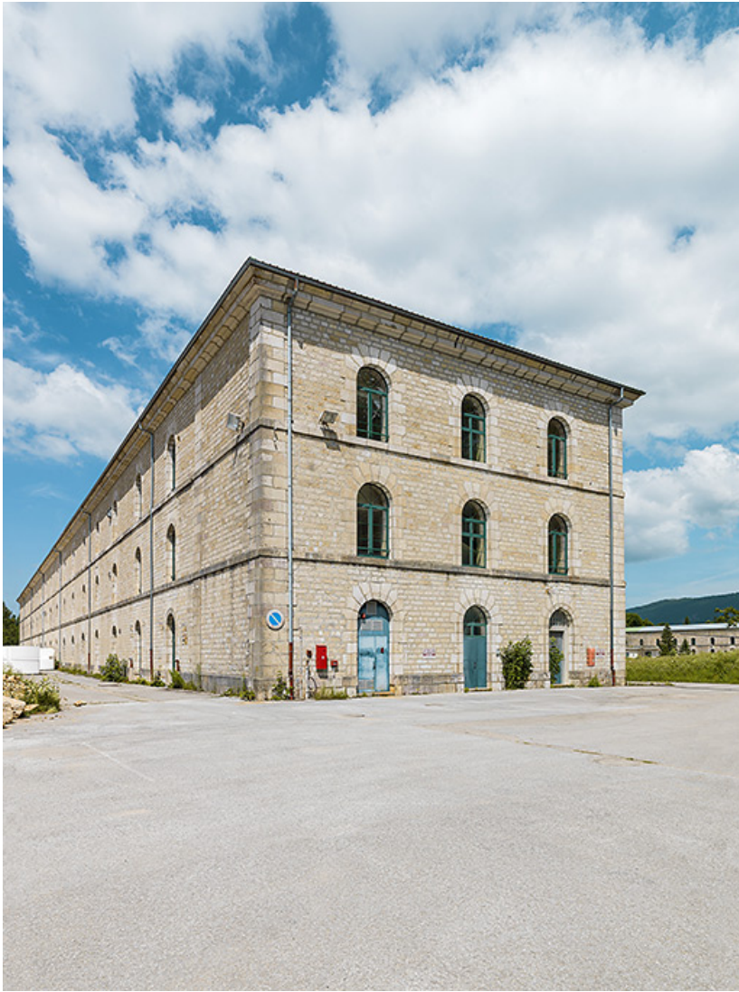
Intérieur de la place : façades latérale et postérieure de la caserne Saint-Germain. 39, Les Rousses R.N. 5
