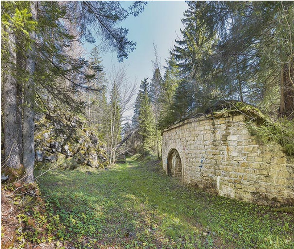
Traverse-abri à la courtine est.
