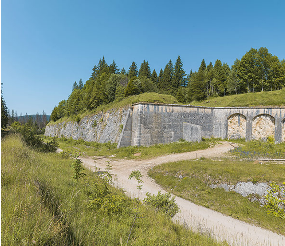
Front est : portion de l'enceinte où le rempart est en roc puis une autre maintenue par des arcs de décharge. 39, Les Rousses R.N. 5
