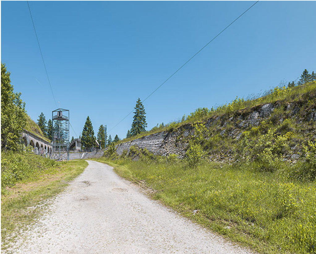
Front est : vue en direction du nord.
