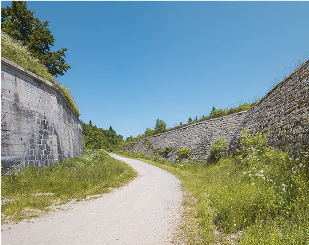
Front est. De gauche à droite : le mur d'escarpe, le fossé et le mur de contrescarpe.
