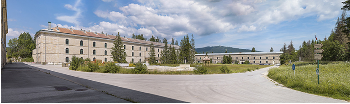
Intérieur de la place : la caserne Quitry à gauche et le cavalier 12 au centre. 39, Les Rousses R.N. 5
