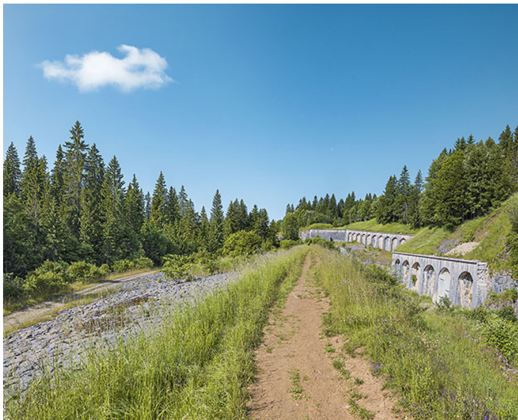
Vue d'une partie du front est. De gauche à droite : le glacis, le chemin couvert et le rempart avec ses arcs de décharge. 39, Les Rousses R.N. 5
