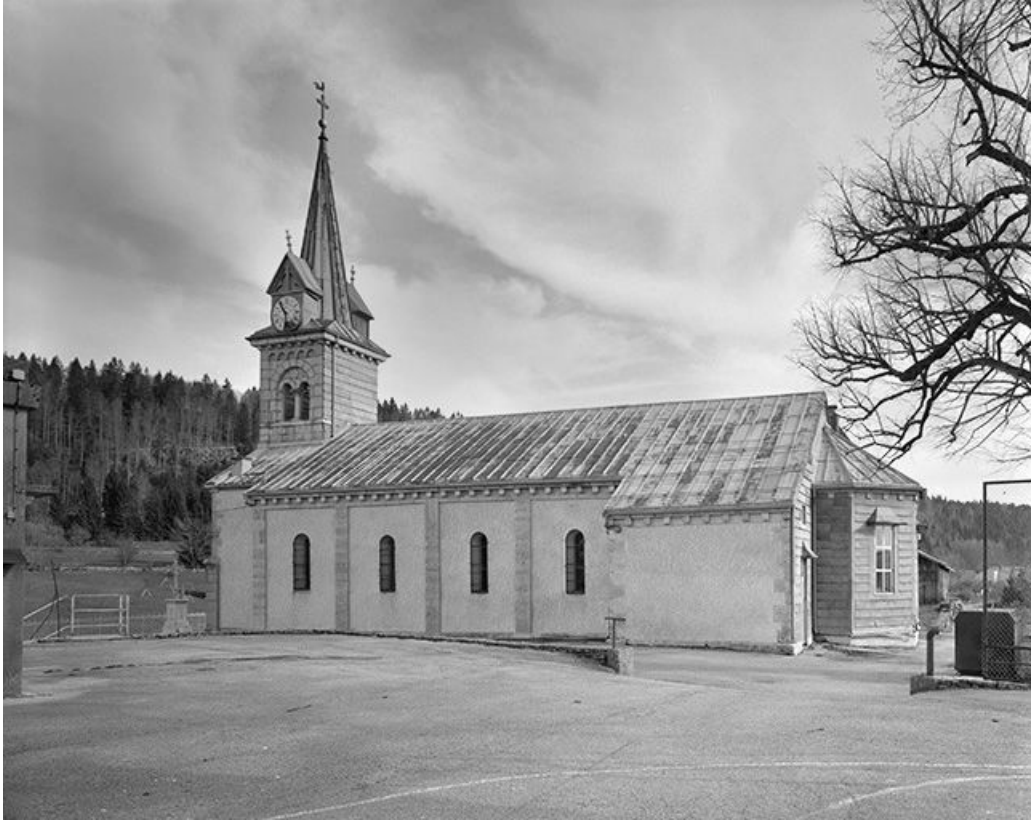
Façade latérale droite.
