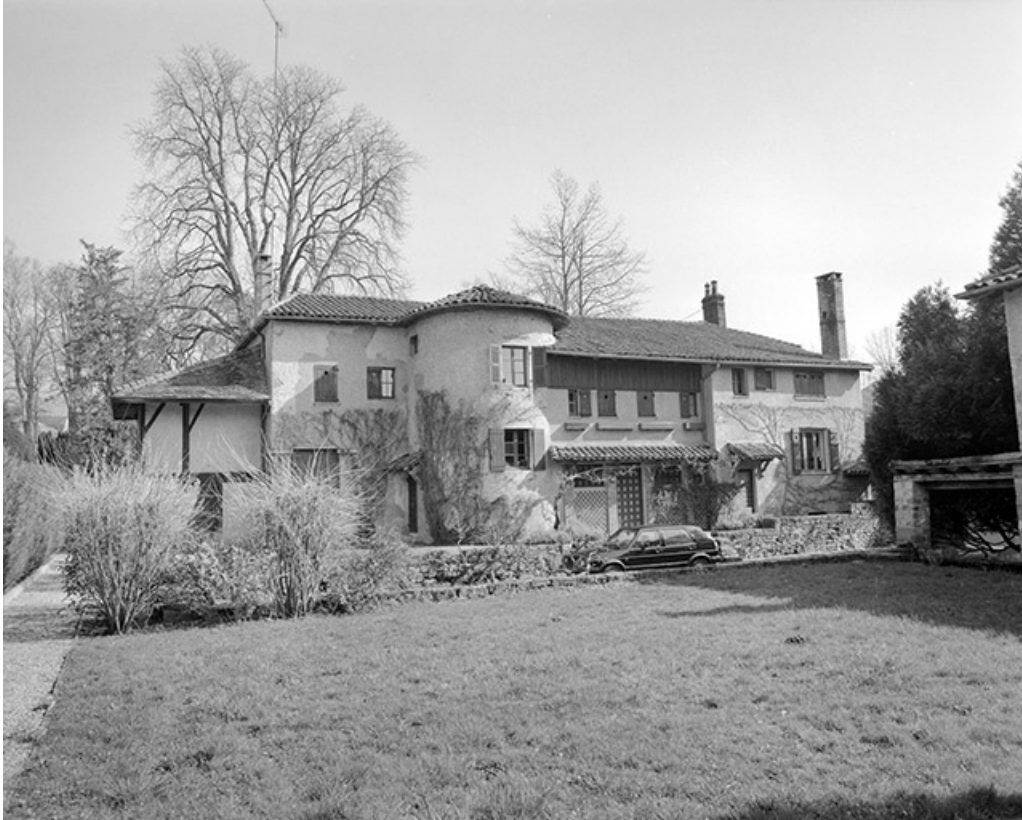
Façade antérieure du logement patronal (O).
