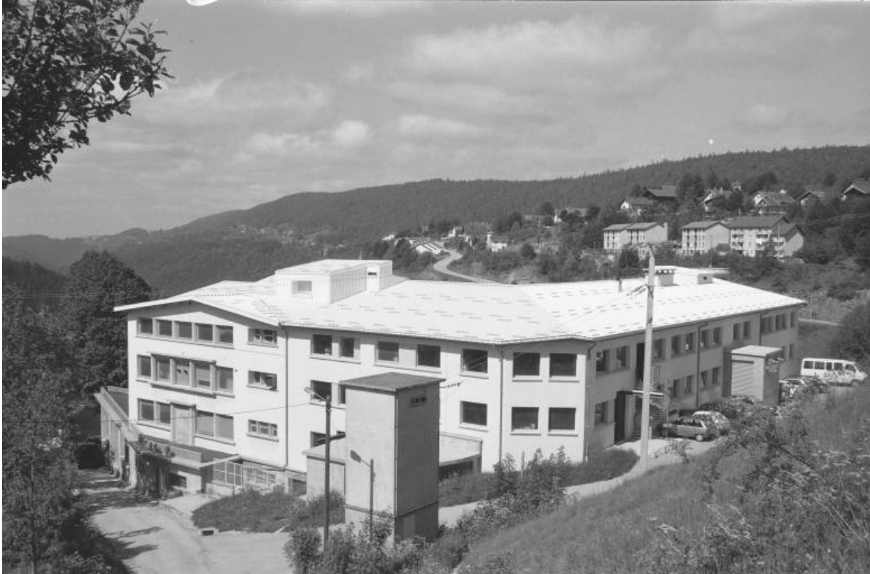
Façade postérieure des ailes nord et est.
