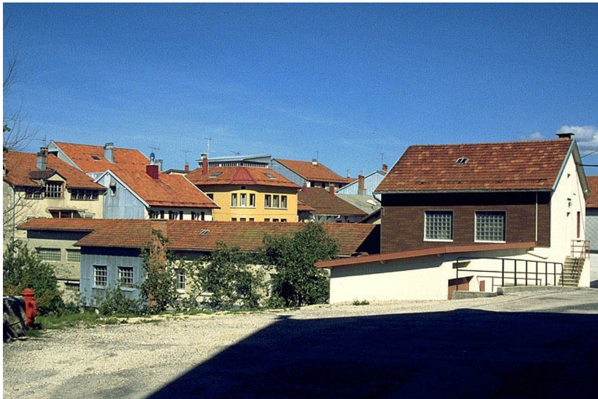
Façade postérieure de l'usine.
