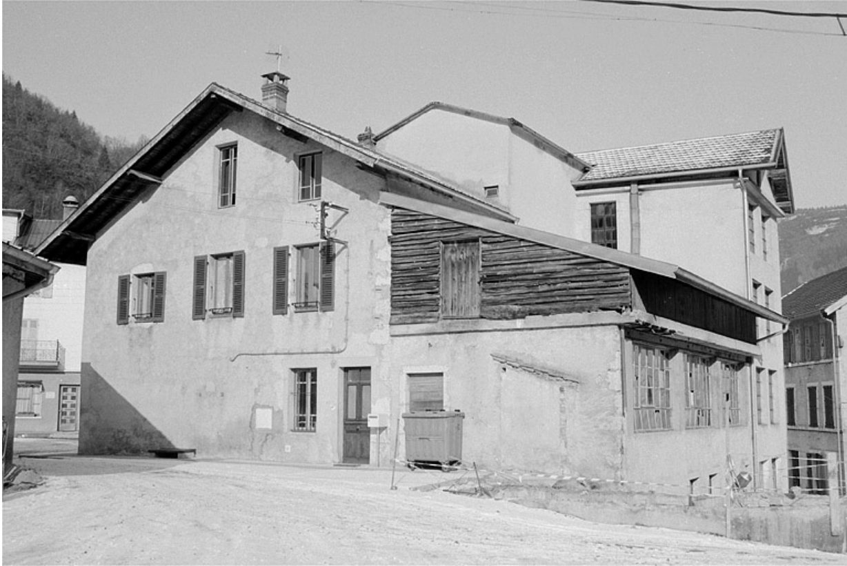
Minoterie, logements et atelier désaffecté.
