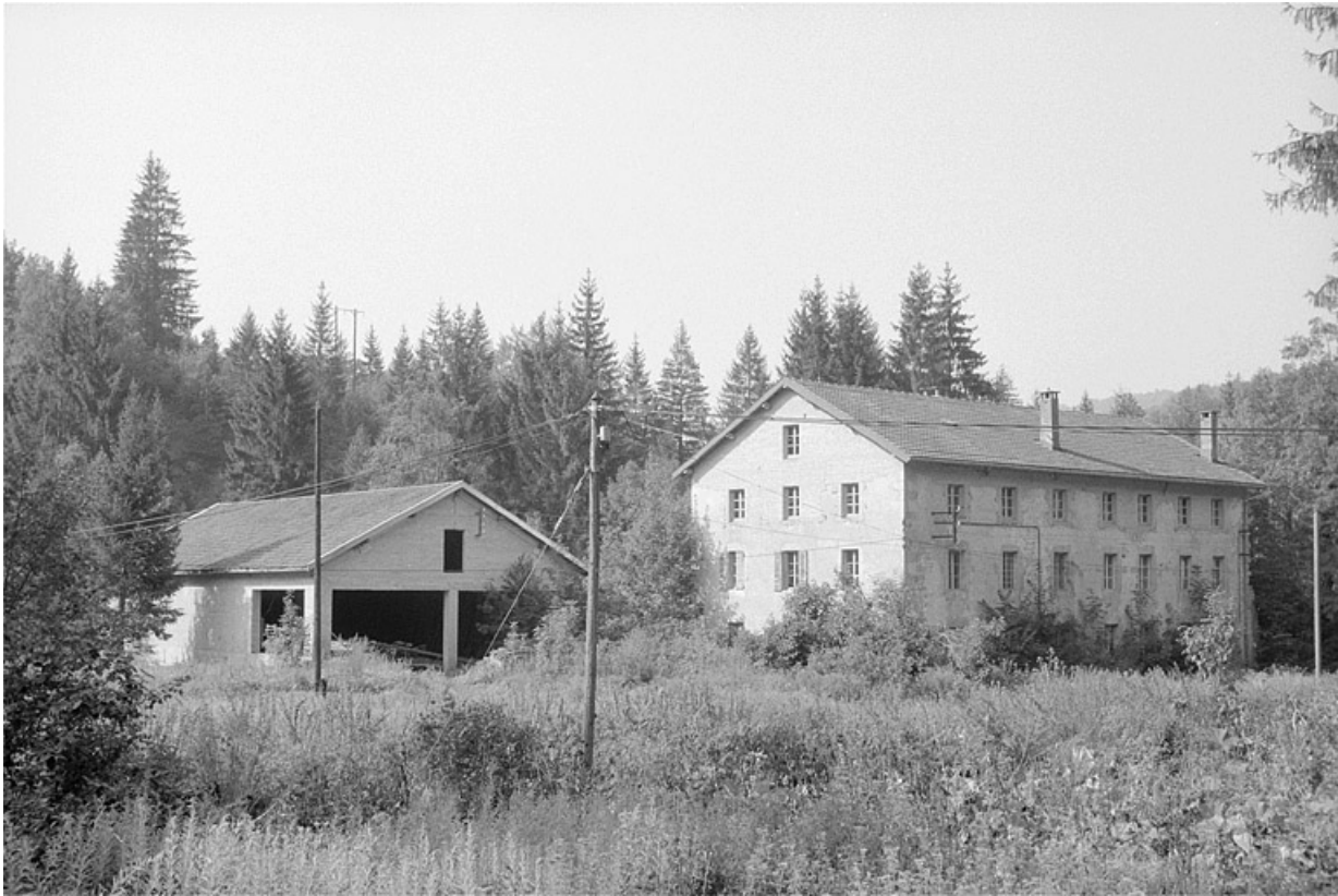
Scierie, logement et atelier de fabrication (E).
