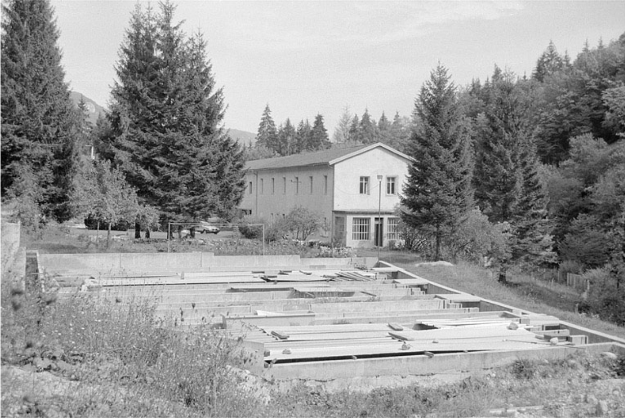
Bassins et bâtiment, depuis le sud-ouest.
