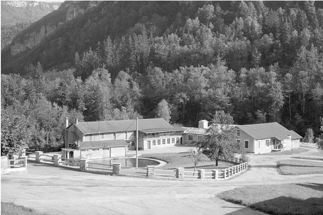
Ancienne usine, vue depuis le nord-ouest.
