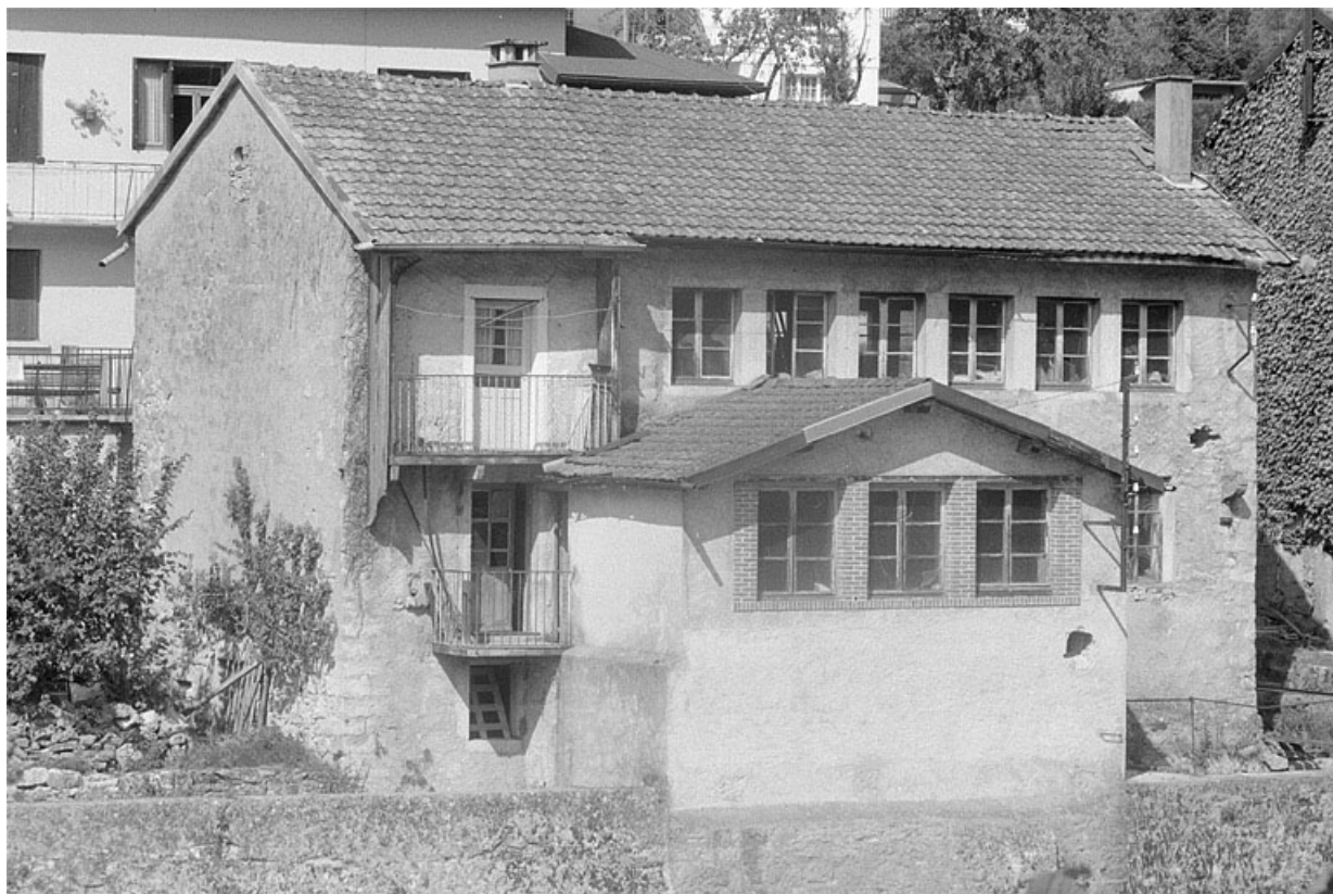
Atelier de fabrication et salle des machines.
