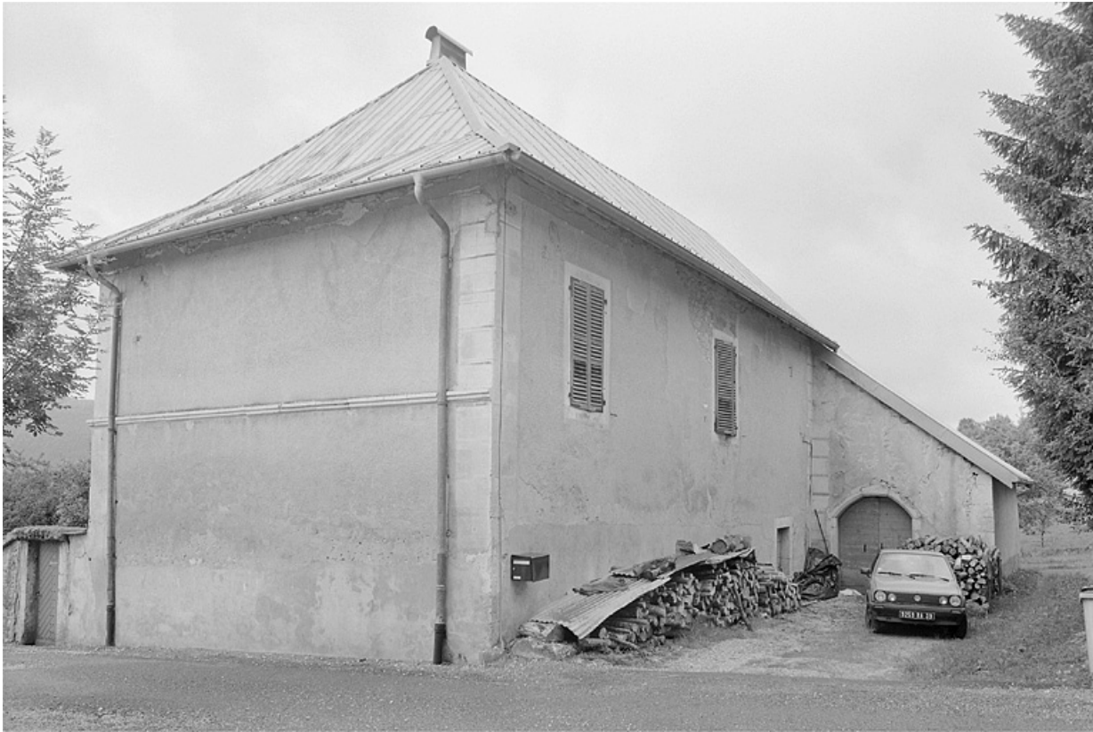
Façade postérieure et face droite.
