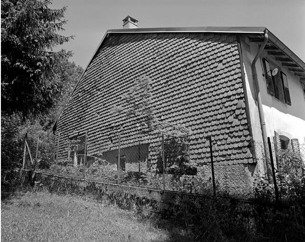
Essentage de tuiles sur un pignon sud-ouest.
