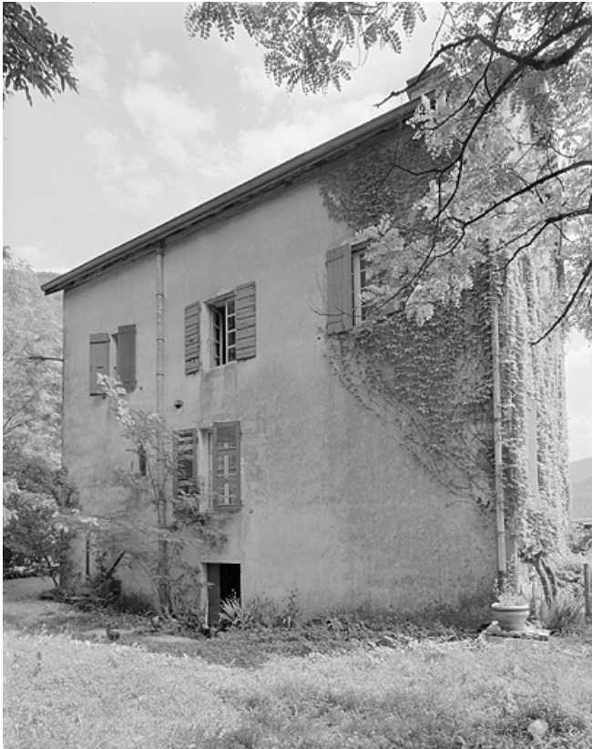
Façade droite avec accès au sous-sol.
