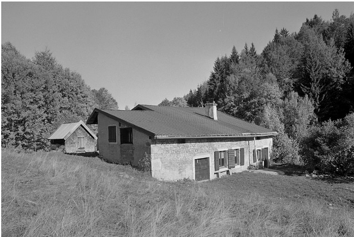
Façade antérieure et face sud-ouest.
