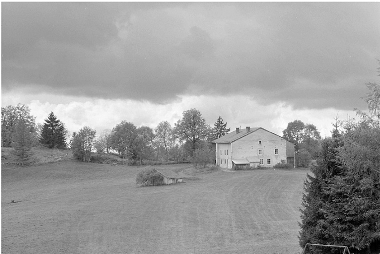
Vue générale depuis l'est.
