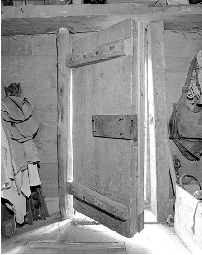
Porte intérieure du grenier fort.
