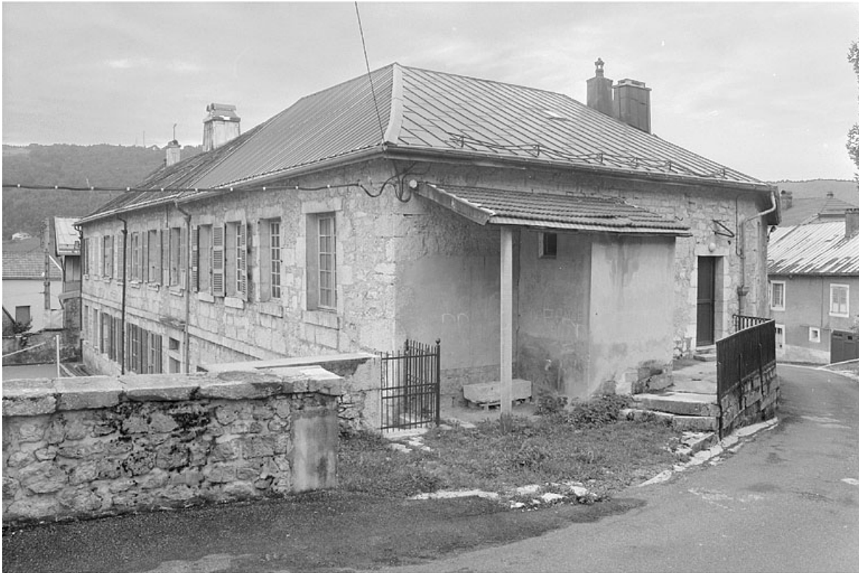
Façade postérieure et face ouest.
