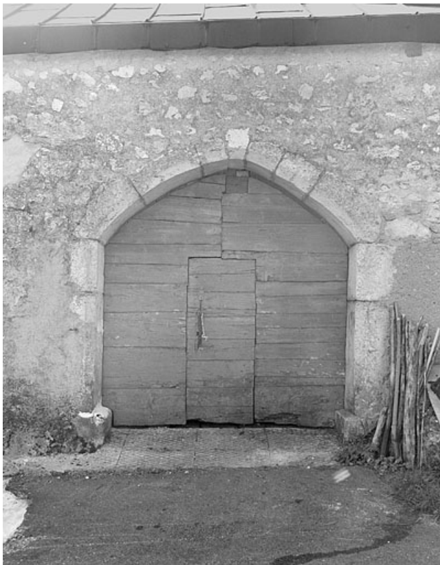
Porte de grange haute.
