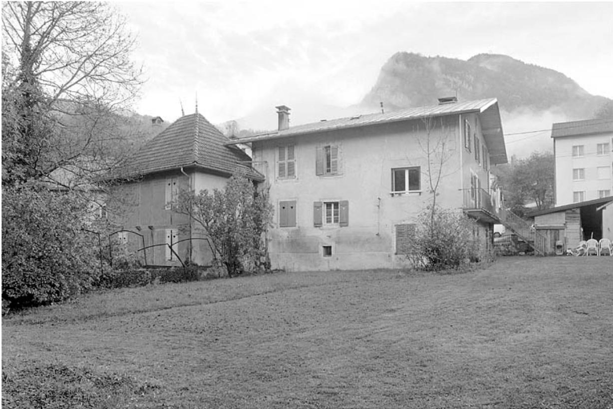
Façade postérieure de l'ensemble.
