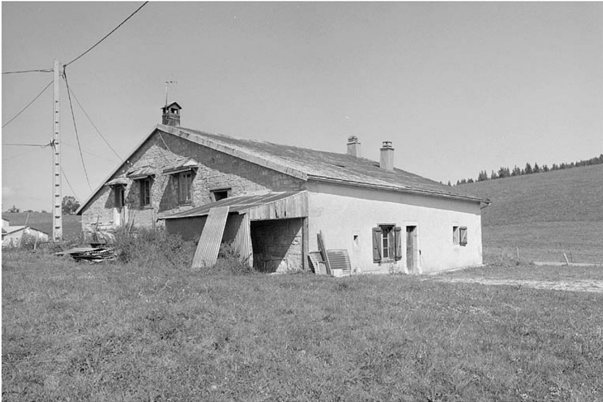
Façade postérieure et face droite.
