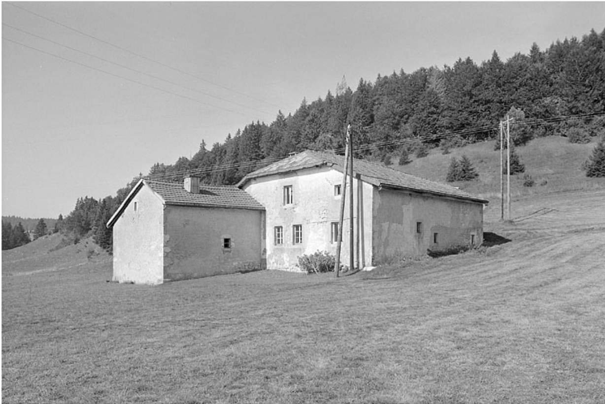
Face sud-est et façade postérieure.
