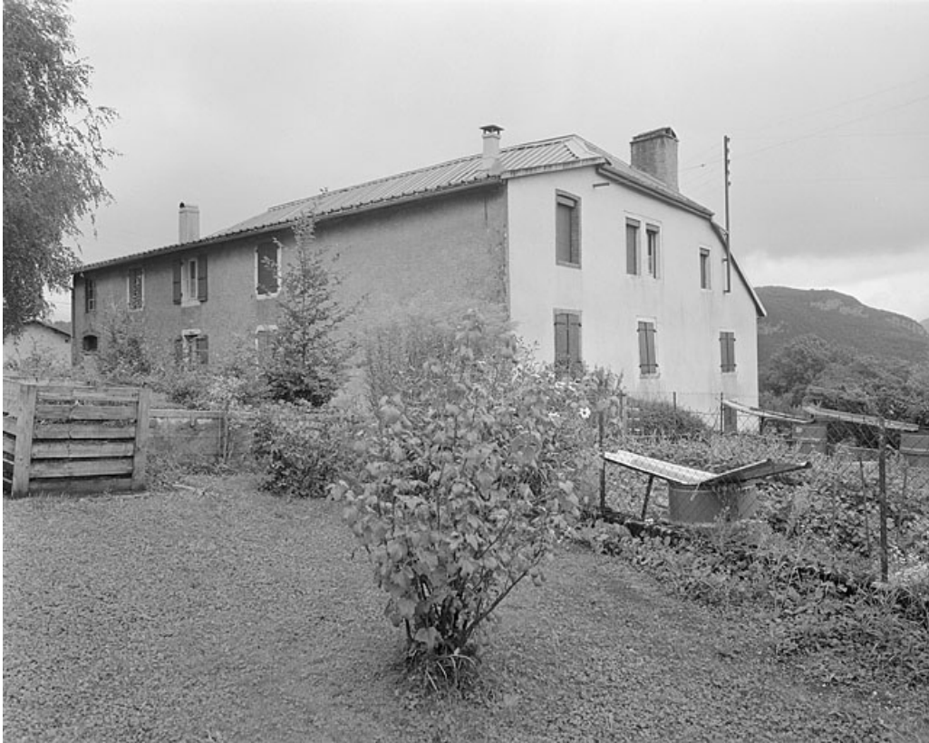
Façade postérieure et face sud.
