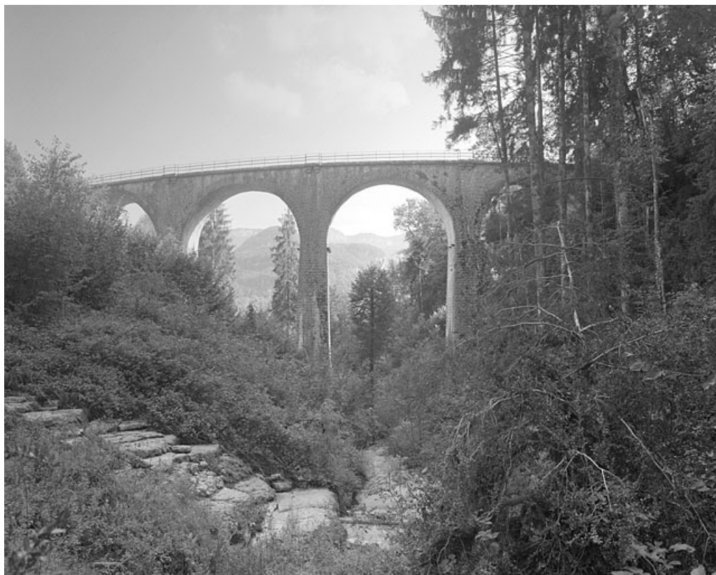
Le viaduc depuis le ruisseau du Nans.
