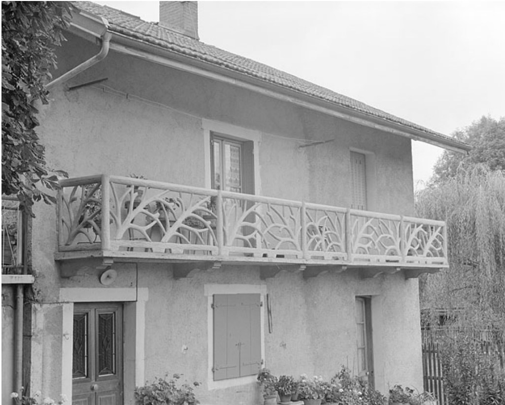
Garde-corps de balcon d'une ferme.
