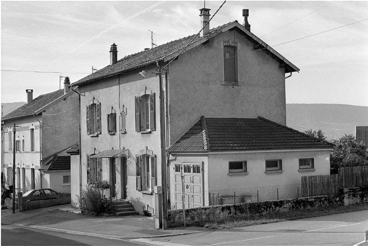
Façade antérieure et face droite.
