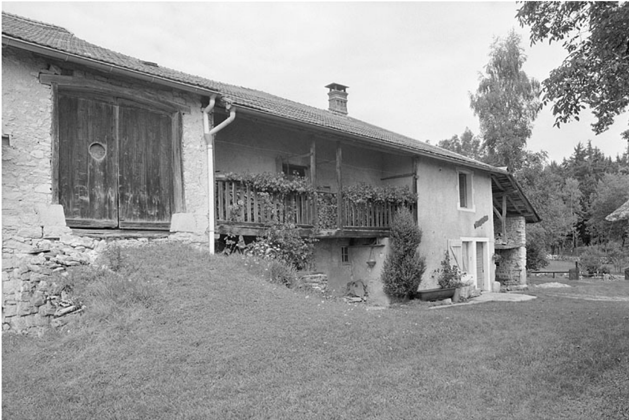
Façade antérieure, balcon en galerie.
