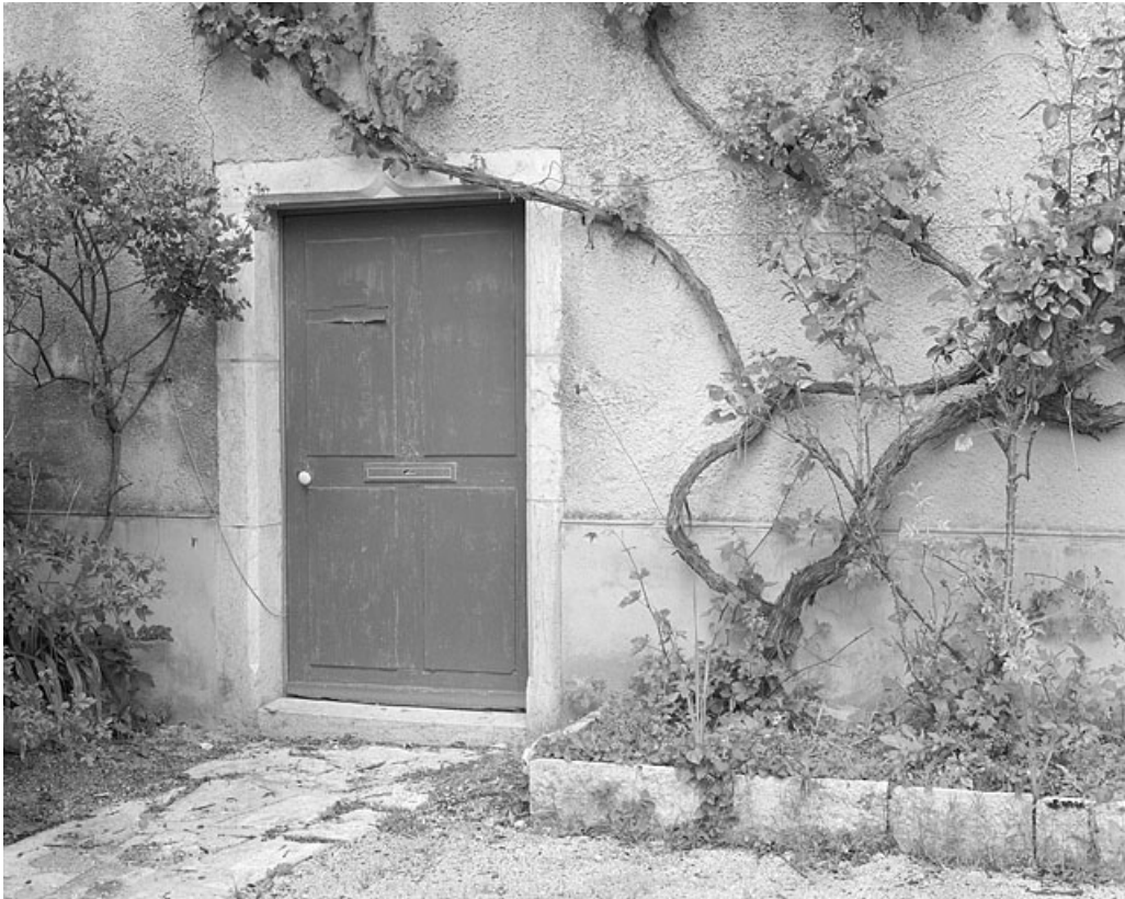
Façade antérieure, détail d'une porte.
