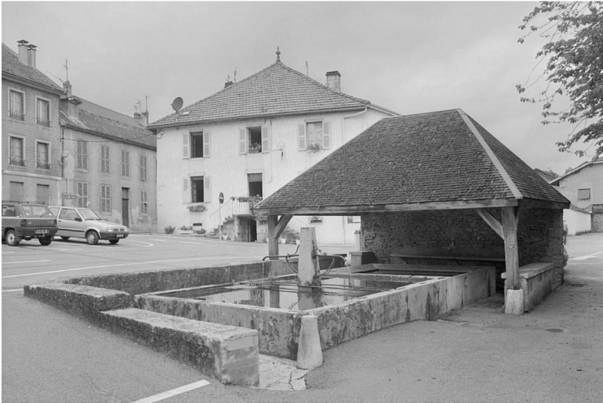
Place de la fontaine, la fontaine-lavoir.
