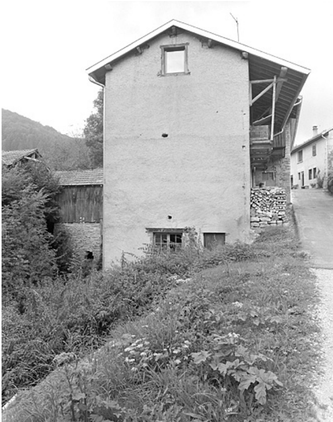
Face gauche de l'atelier de tournerie.
