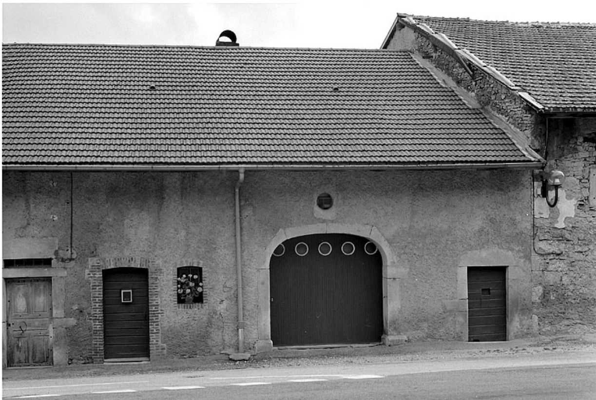
Façade sur la rue.
