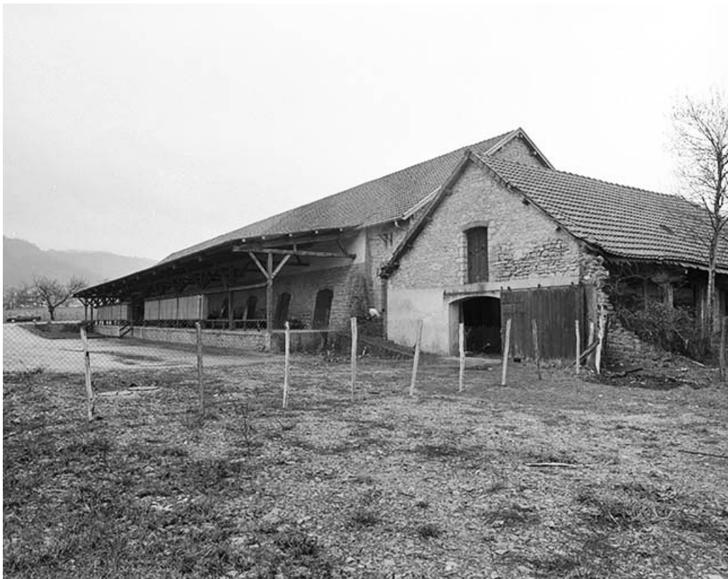
Magasin industriel et atelier de fabrication ruiné.
