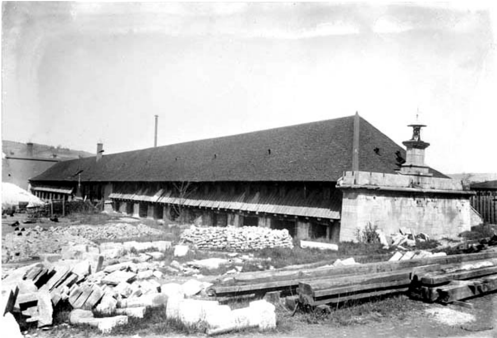
[Bâtiment de décantation de l'eau salée].
