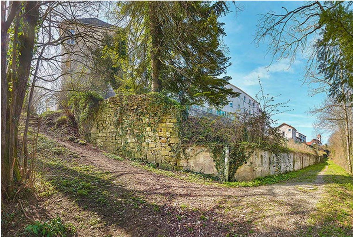
Mur d'enceinte dans le prolongement du front.
