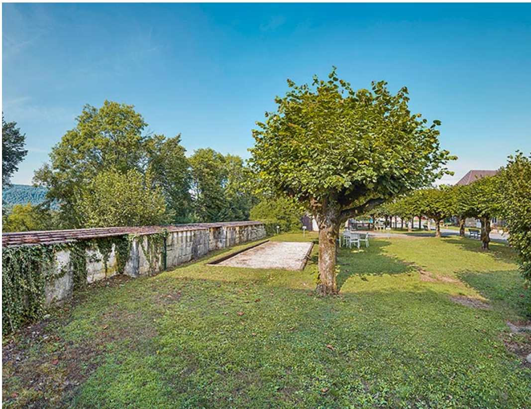
La cortine sud, vue depuis la cour intérieure.
