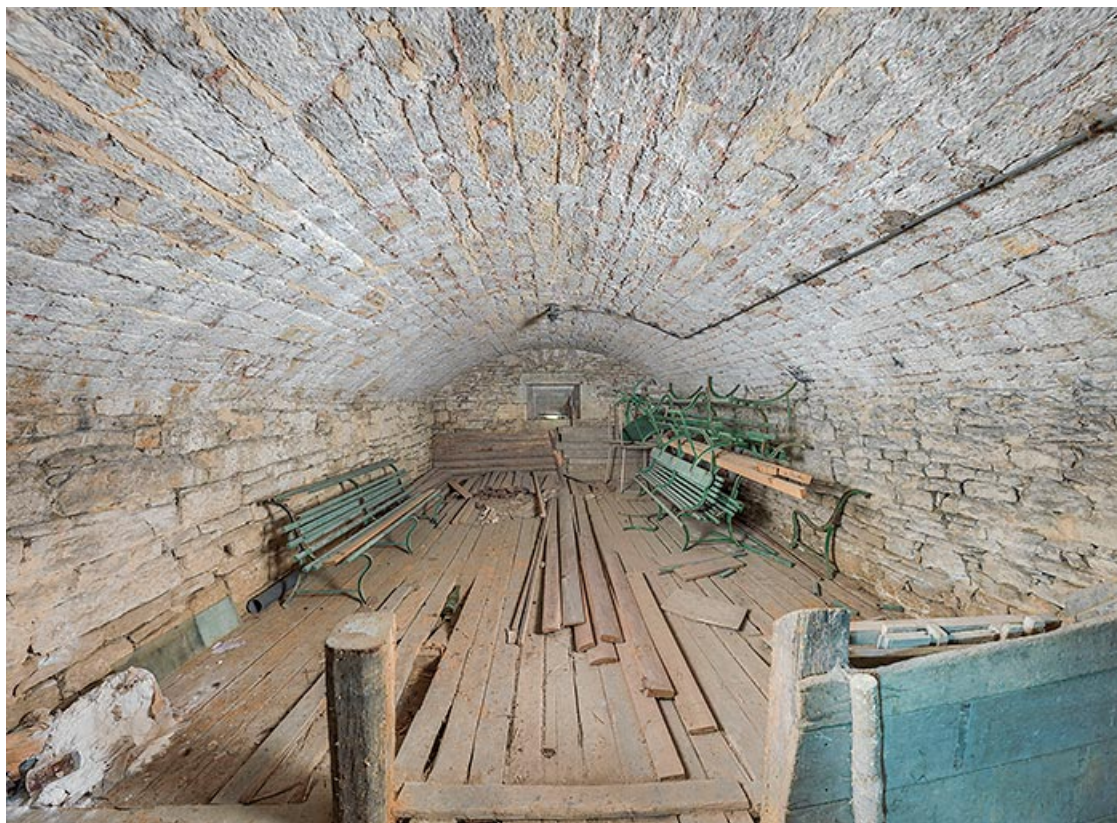
Casemate et sa voûte à l'épreuve.
