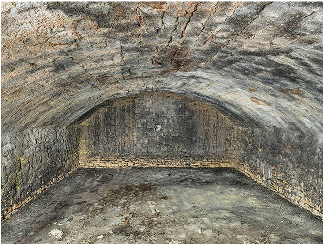
Autre casemate du niveau inférieur.
