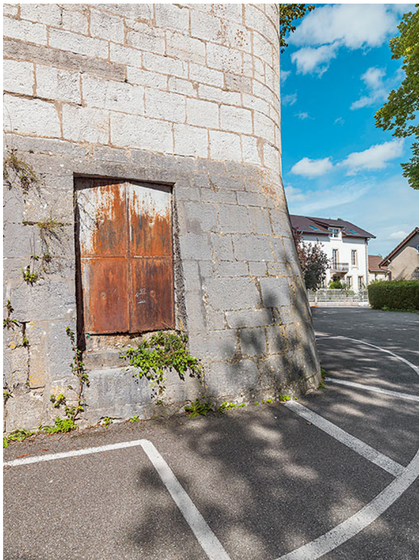
Poterne du demi-bastion.
