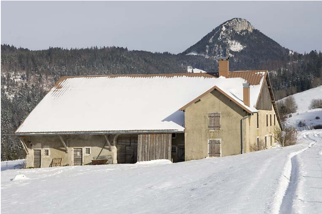
Façades antérieure et latérale droite, en hiver.
