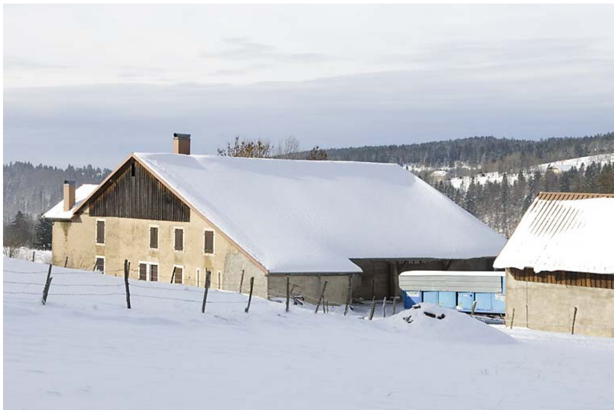
Façades postérieure et latérale droite, en hiver.
