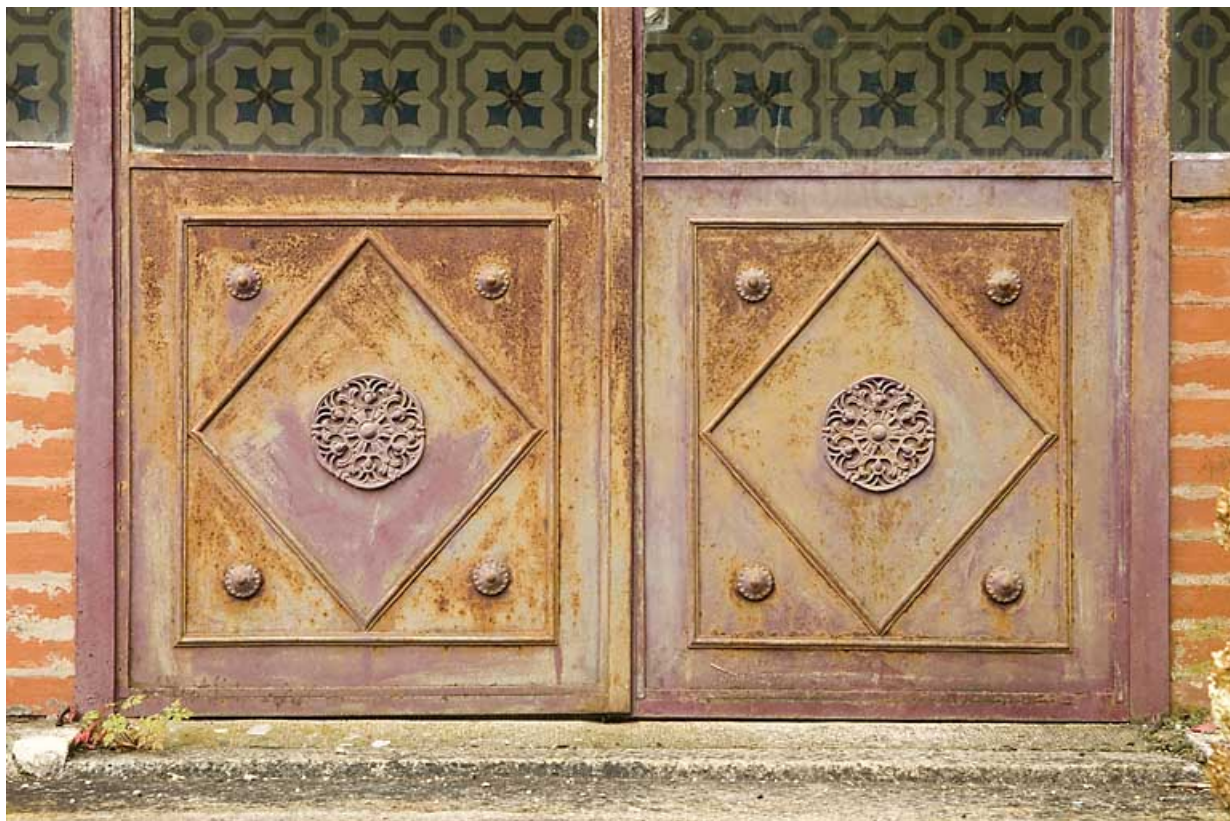
Serre : ferronnerie de la porte.
