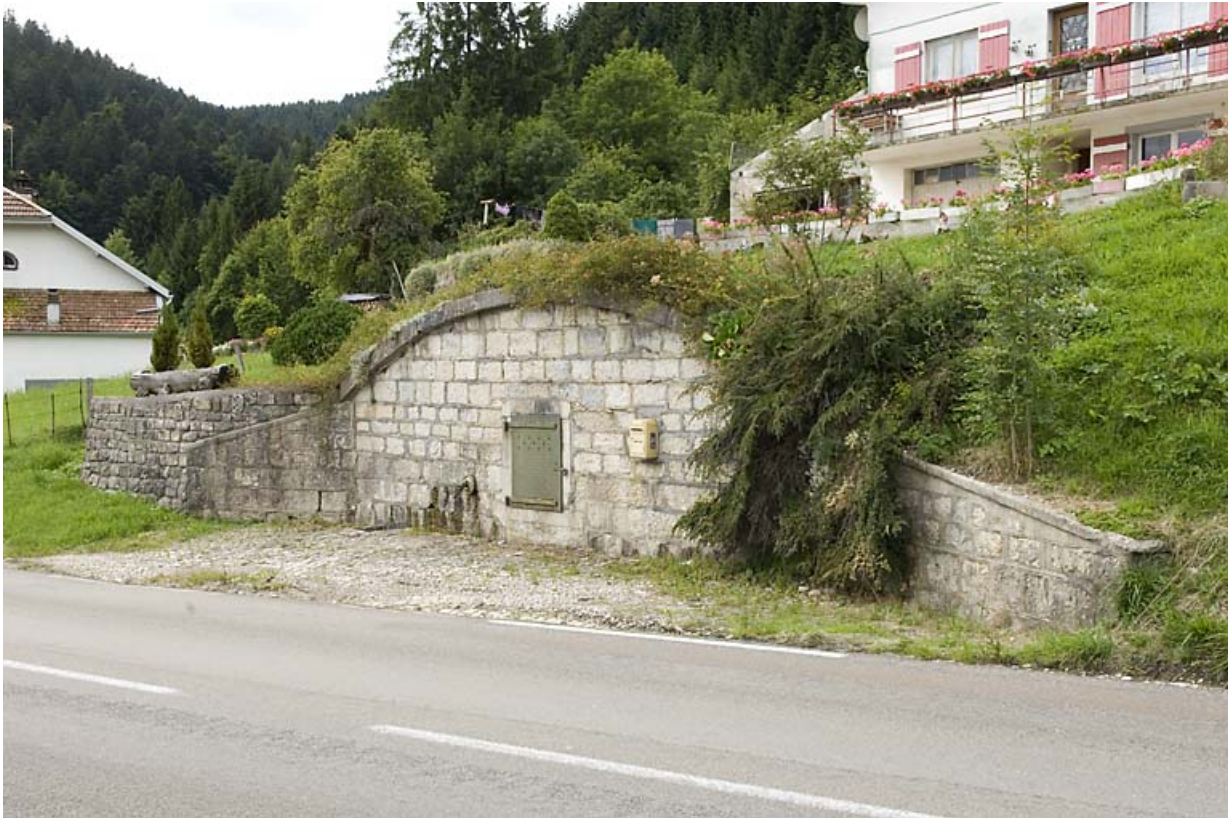
Réservoir des Tavins (route de Vallorbe, 2008 AH 16).
