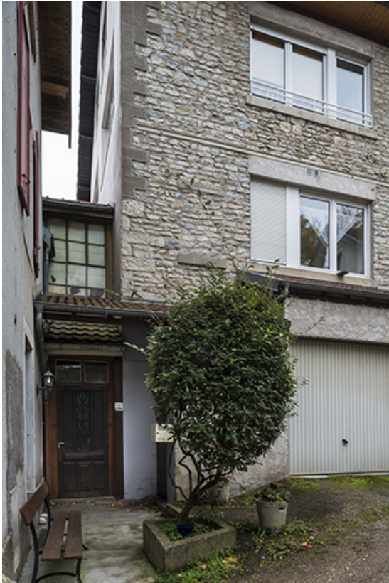
Extrémité sud de l'atelier de fabrication.
