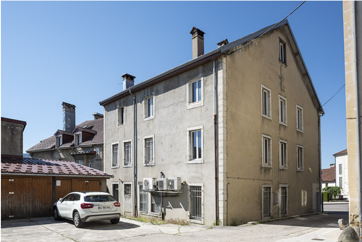
Façades postérieure et latérale gauche.
