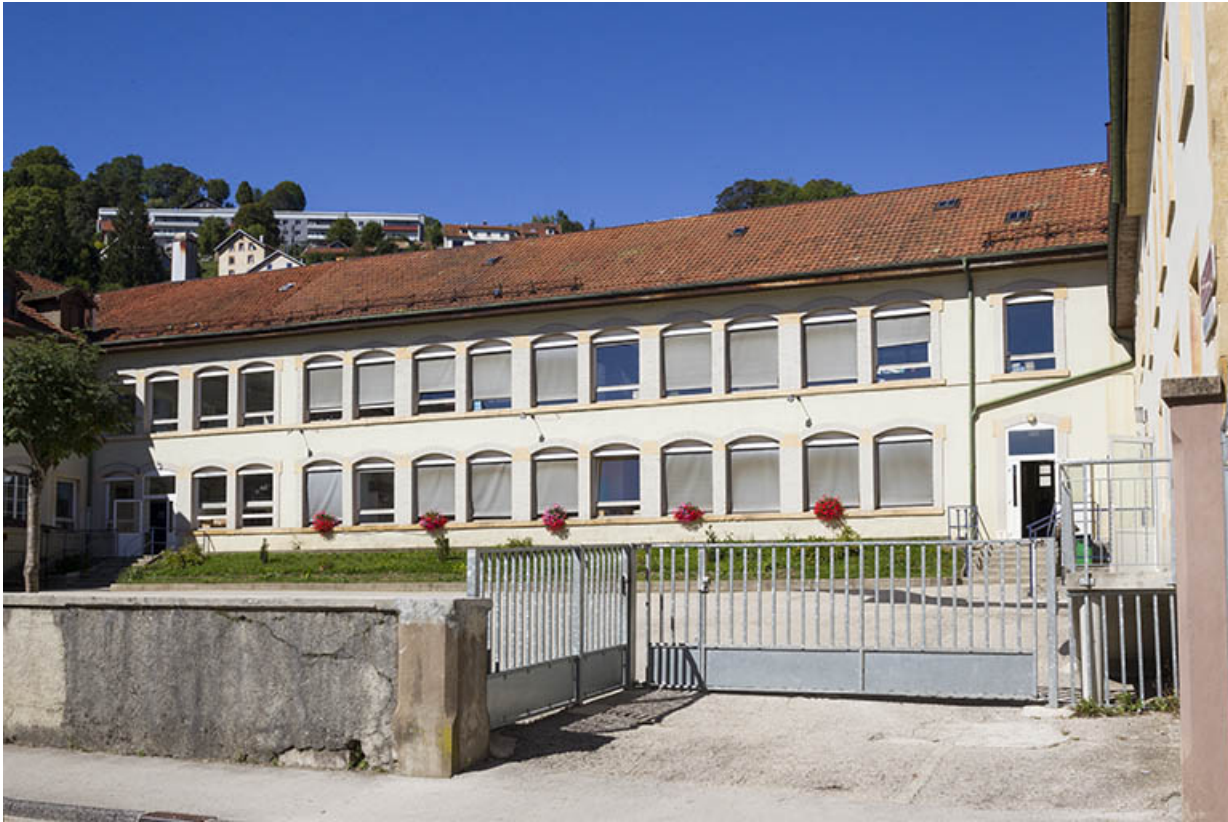
Aile nord : façade antérieure.
