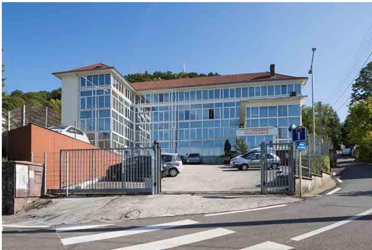
Vu d'ensemble depuis le nord-ouest.
